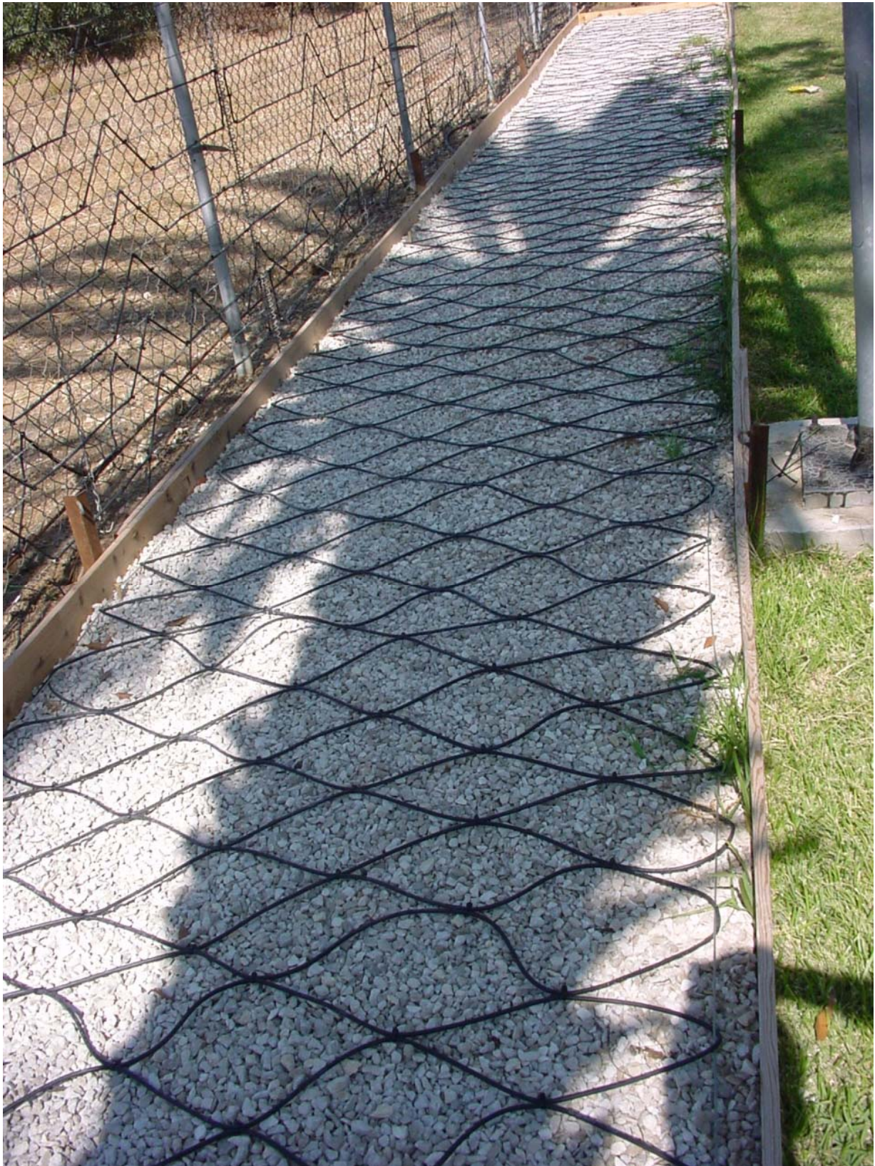
ระบบป้องกันการบุกรุกพื้นที่ด้วย Super Sensor Cable ในพื้นดินโดยตรง
